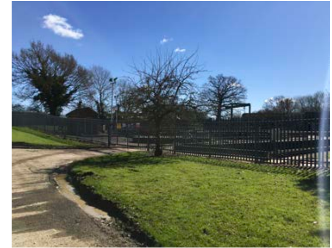
WWTW (odour zone)
